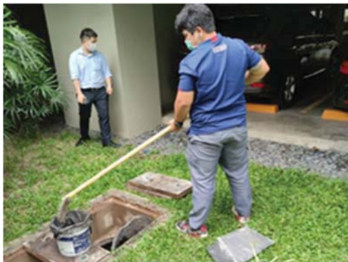
การตักไขมันออกจากกระบบบำบัดน้ำเสีย
