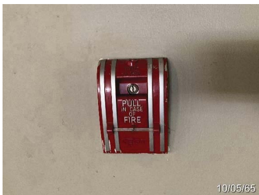
อุปกรณ์แจ้งเหตุเพลิงไหม้แบบมีออก
