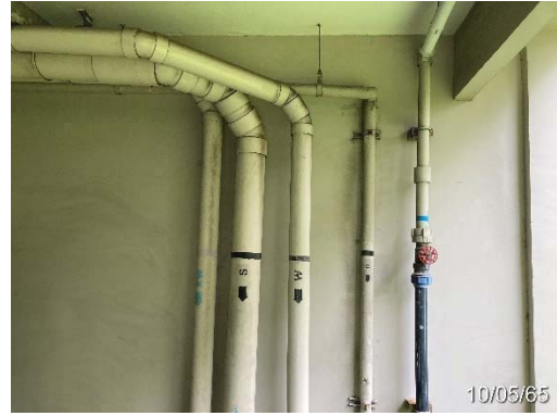
ท่อรวมน้ำเสียภายในอาคารโครงการ
