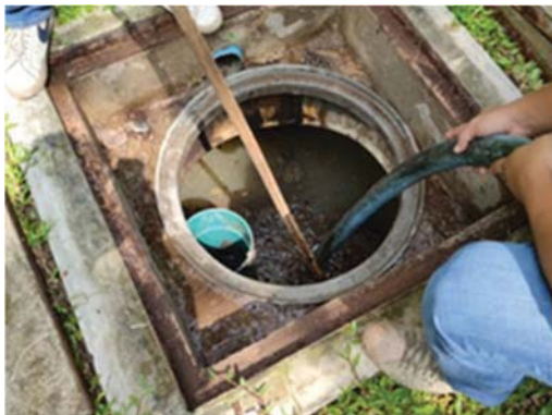
การตักไขมันออกจากกระบบบำบัดน้ำเสีย
