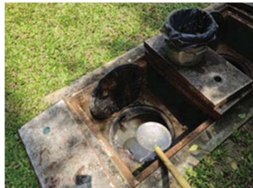
การตักไขมันออกจากกระบบบำบัดน้ำเสีย
