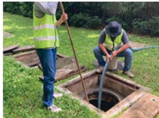
การตักไขมันออกจากกระบบบำบัดน้ำเสีย
