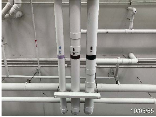
ท่อรวมน้ำเสียภายในอาคารโครงการ
