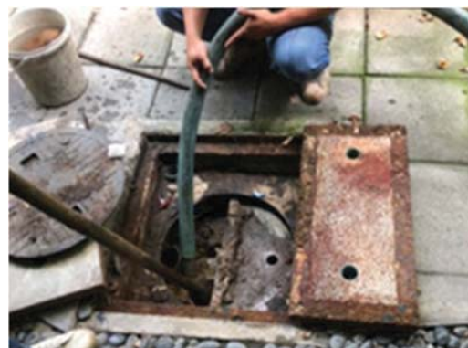
การสูบน้ำส่วนเกินระบบบำบัดน้ำเสีย
